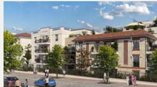
AVENUE CAVAIGNAC À SAINT-MAUR-DES-FOSSÉS (94)
